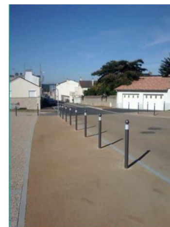
Potelets en acier avec catadioptrés - BRESSUIRE
