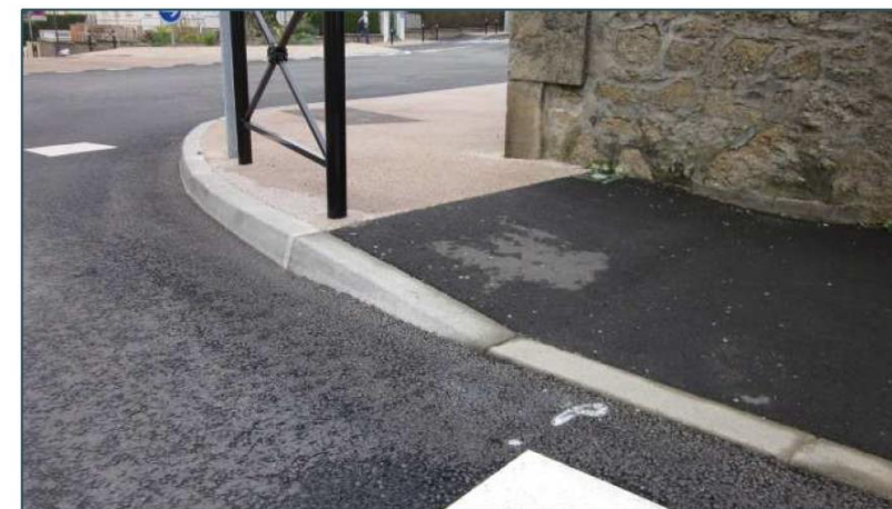
Aménagement d'une dépression en bordure T2 haute variant de 14 cm à 2 cm de vue - BRESSUIRE
