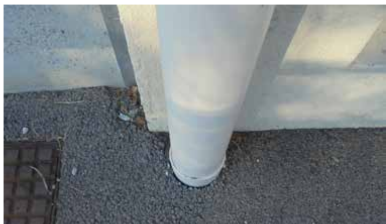
Exemple d'une descente de cheneau hermétique
