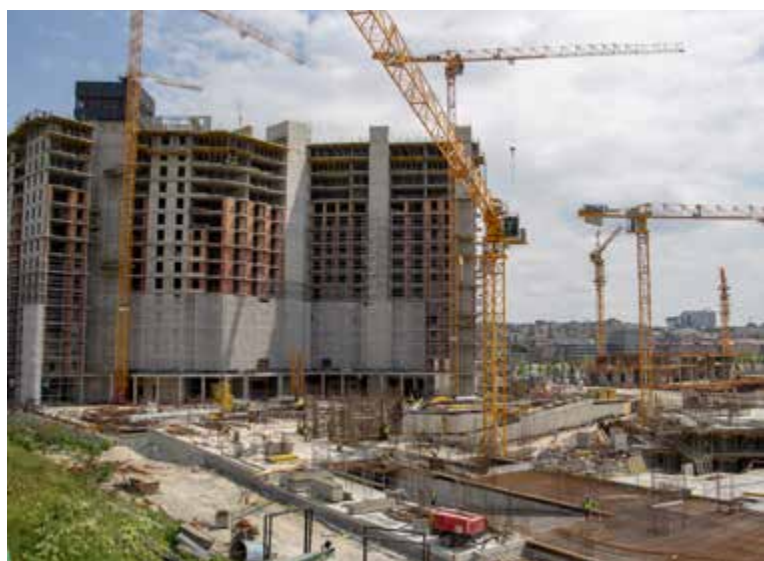
Chantier de construction
